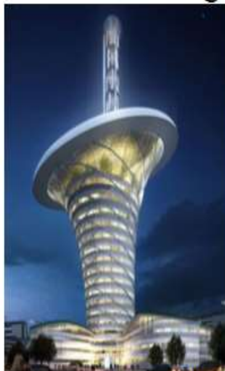
مبنى الطاقة ببيكين
